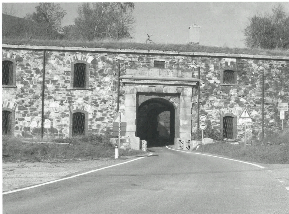
Un particolare del Forte del Melogno, attraversato dalla strada Finale-Calizzano.
