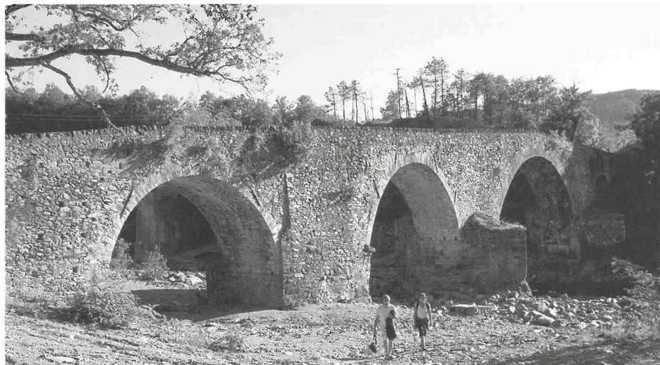
Tiglieto: il poderoso ponte sull'Orba, restaurato nel 1667, fu percorso anche da autoveicoli fino alla costruzione del ponte moderno. A sinistra sporgono alcuni rami di un'enorme quercia (Quercus petraea), uno degli alberi monumentali censiti dalla Regione Liguria (alta 16 m e con una circonferenza di 455 cm, dovrebbe avere almeno 300 anni).
