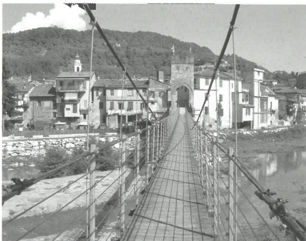
Millesimo: il ponte della Gaietta.
